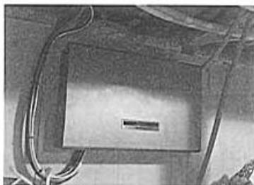
床下に設置した「パワコン」。冬は暖房器代わり
