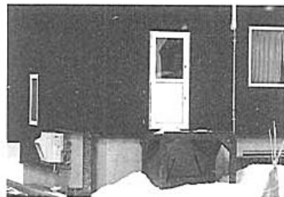
西面に設置したエコキュートの室外機。風で雪が飛ばされ、雪どけが最も早い
